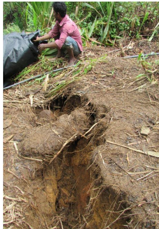
(d) Open tension crack
