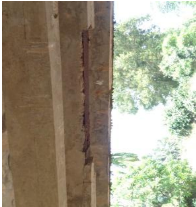
1- spalling - 5000 mmx200 mm
